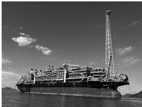
FPSO Almirante Barroso MV32
