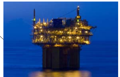
据付完了 Shenzi TLP
