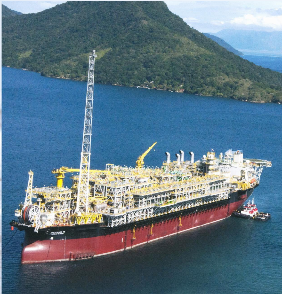
FPSO Cidade de Itaguai MV26
