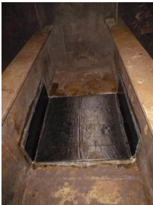
CFRPによるボトムプレート補修
