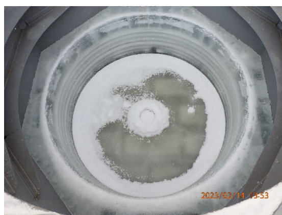
掘削後のタンク内大型氷の様子
